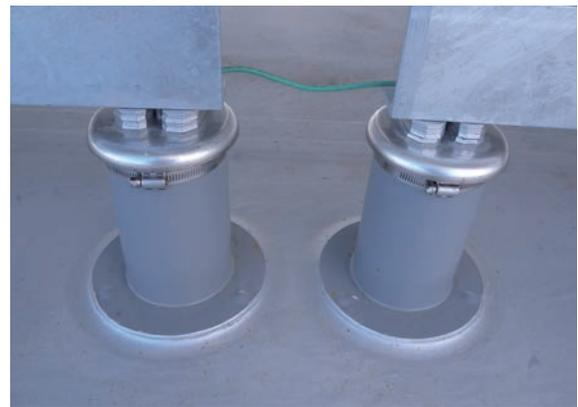
鋼管にゴムを被覆した架台を使用し劣化防止
