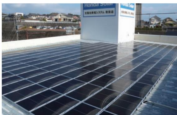
整備工場屋上の太陽光パネル (折り屋根に平置き設置)
