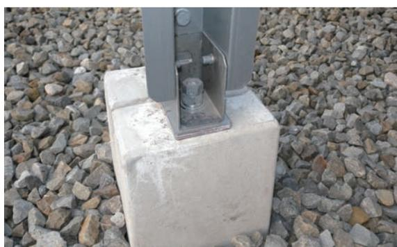
架台基礎ブロックは50cm程度埋設させて台風にも耐えるようにしています。
