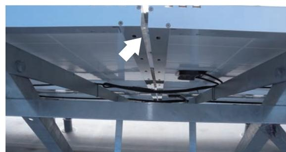
屋上設置ですので台風等強風による風圧を逃がす為に隙間を開けています。
