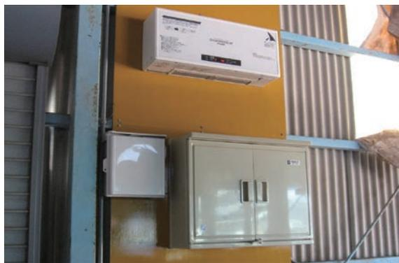
倉庫壁に設置されたパワーコンディショナー(上)とブレーカー(右下)、ワイヤレス送信機(左下)
