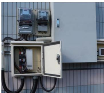
売電計量器(左上)、ワイヤレス送信機(左下)、表示機(右)の設置状況
