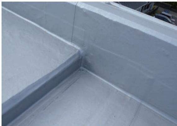
屋上床面にラバー製の防水シートを敷き防水処置実施
