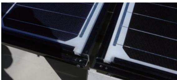
降灰を洗浄した後に水が流れる様にパネルは水抜き用切り込み構造になっています。
