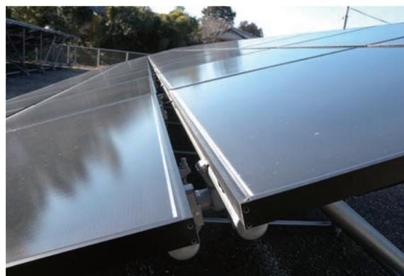
台風などの強風時に破損しない様にモジュール間に一定の隙間を開けて設置しています。
