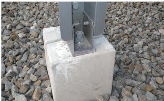
架台基礎ブロックは50cm程度埋設させて台風にも耐えるようにしています。
